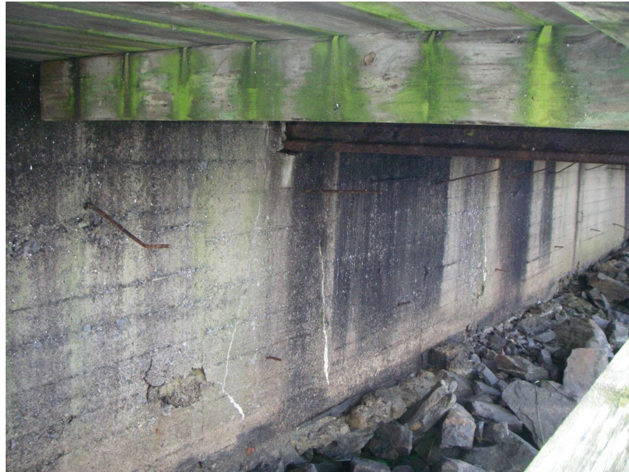
8. Betongkaj, delområde C
